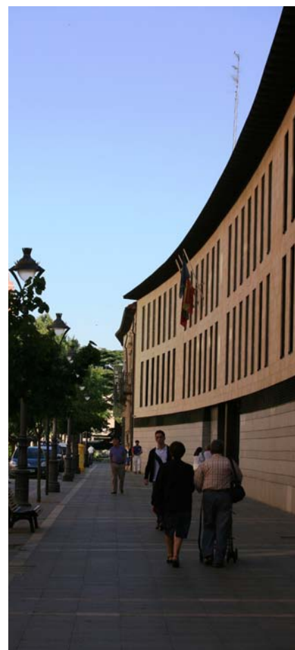
Sede del Registro Civil de Valladolid
